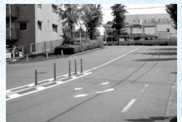
坂道になった嵩上げ工事の境界部。(港区市岡1・2丁目)
