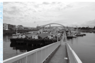
大正内港(大正区千鳥3丁目付近から撮影)
