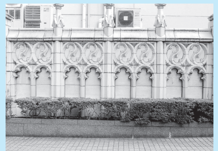
大同生命日本社ビルから移設された外壁装飾
