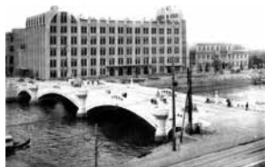
近代建築が建ち並ぶ大大阪。堂島川の向こう、左が大阪中央電信局、右が大阪商工会議所。『大大阪橋梁選集』より
